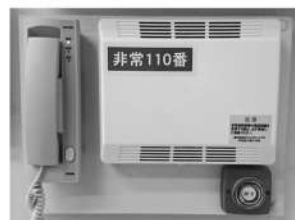
↑非常通報装置
